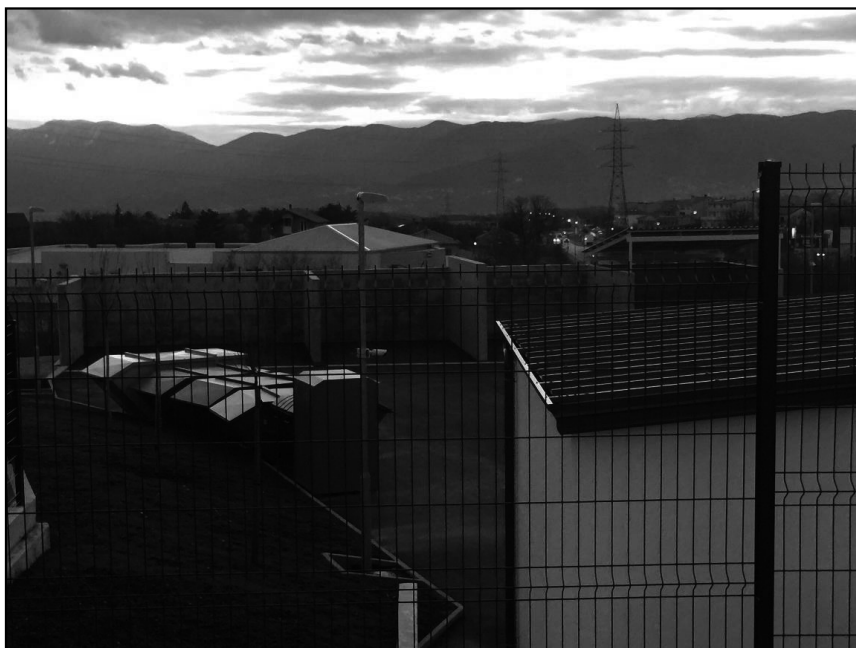
Slika 8: Fotografije reciklažnog dvorišta
