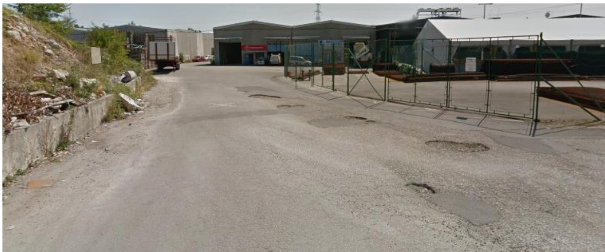
Slika 3. Oštećenja kolnika
