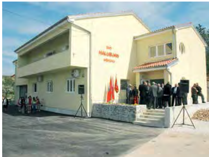
Novi vatrogasni Dom svečano je otvoren povodom Dana Općine 2007. godine. U sklopu uređenja vatrogasnog doma nadograđen je novi kat, postavljen novi ulaz u objekt, krov i fasada.
